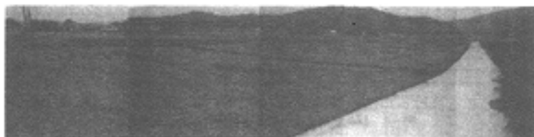
写真-6 施工前の現況
