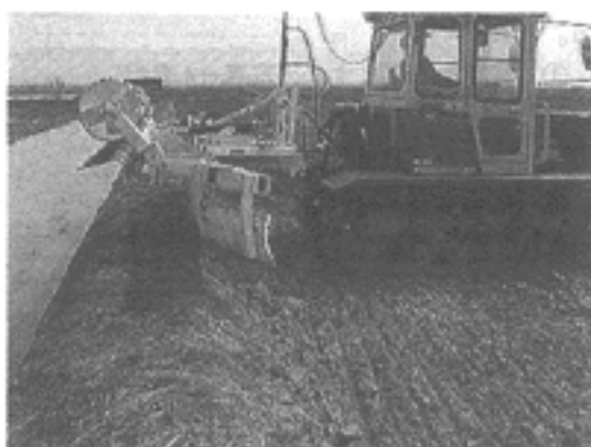
写真-3 畦際の作業
