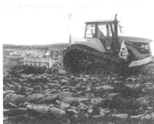
写真-2 レーザブロー作業
