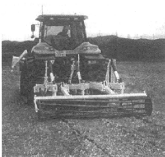
写真-1 ハンプブレーカ作業
