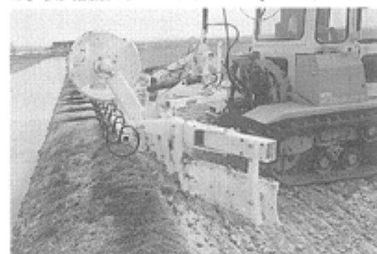
写真6 レーザーレベラーの畦際の作業状況
